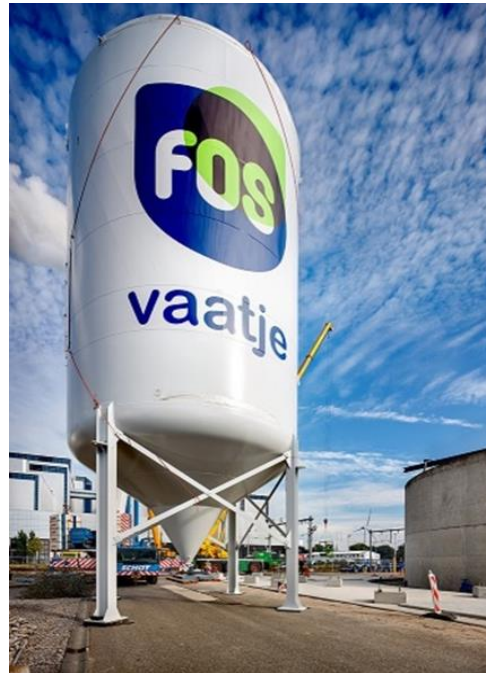
FIGUUR 1 | WINNING VAN STRUVIET UIT AFVALWATER IN AMSTERDAM-WEST (BRON: WATERNET)
