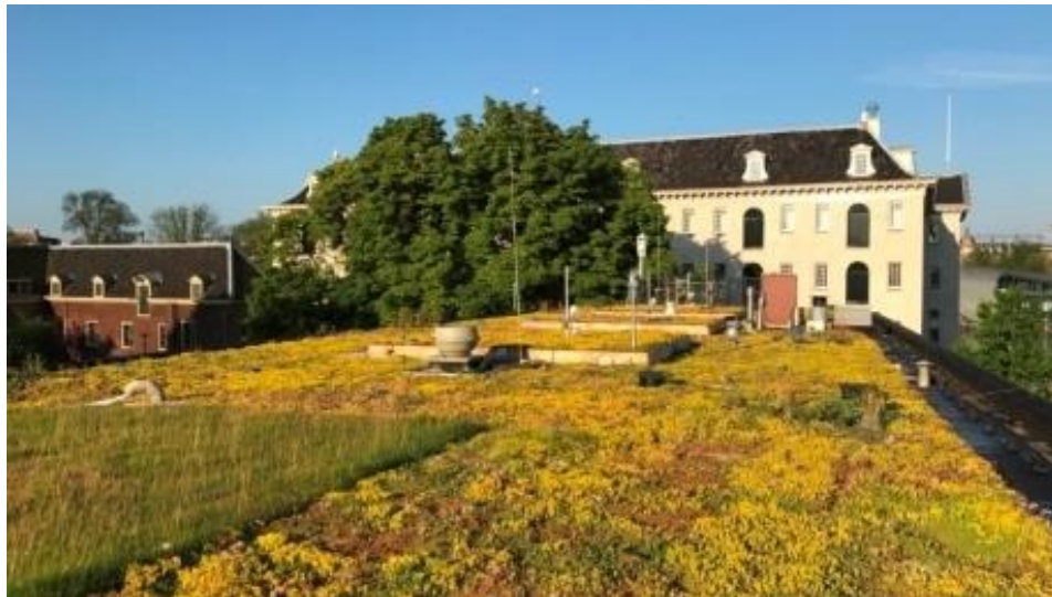
FIGUUR 3 | IN 2017 IS OP HET MARINETERRAIN IN AMSTERDAM HET INNOVATIEVE, BLAUW-GROENE DAK SMARTROOF 2.0 GEOPEND. OP DIT DAK WORDT DE KOMENDE TWEE JAAR WETENSCHAPPELIJK ONDERZOEK GEDAAN NAAR HET KOELEND EFFECT VAN VERDAMPING EN HET TEGENGAAN VAN HET STEDELIJK HITTE-EILAND-EFFECT. OOK KAN HET DAK INTENSE REGENBUIEN OPVANGEN EN DAARMEE WATEROVERLAST VOORKOMEN.
