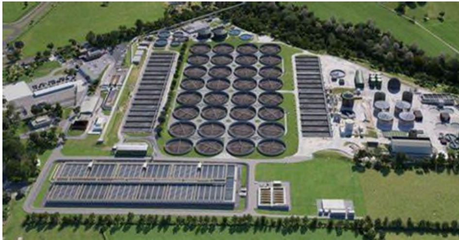
Figuur 17: Blackburn (UK) is de grootste zuiveringsinstallatie die gebruik maakt van de Nederlandse Nereda®-technologie
