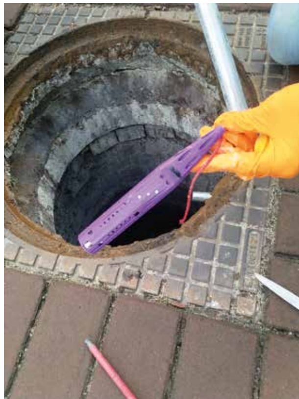
Afbeelding 1. Een passieve sampler wordt na 48 uur monsternamming uit het riool gehaald
