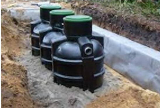
Figuur 1: IBA compact systeem, gebruikt voor pilot bij Waterschap Zuiderzeeland
