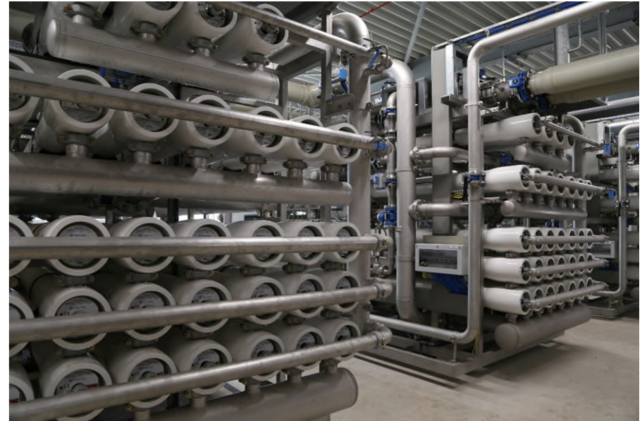
One Step Reverse Osmosis (OSRO) voor de productie van drinkwater is ontwikkeld door Oasen
