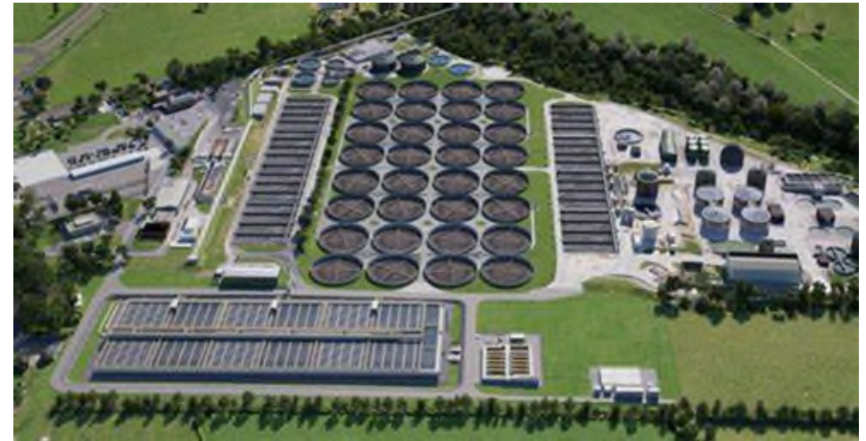
Blackburn (UK) is de grootste afvalwaterzuiveringsinstallatie die gebruik maakt van de Nederlandse Nereda®-technologie
