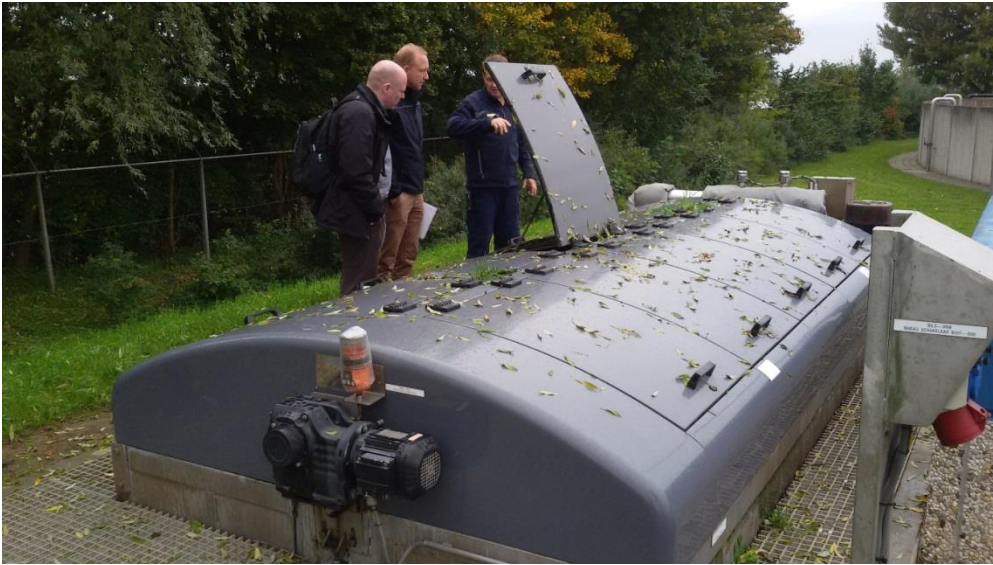
FIGUUR IV-4 DISC FILTER INSTALLATIE RWZI DEVENTER (600 M 3 /H MET 90,2 M 2 DOEK (16 SCHIJVEN MET FILTERDOEK AAN WEERSZIJDEN), UIT TE BREIDEN IN BESTAANDE OMKASTING TOT 750 M 3 /H).
