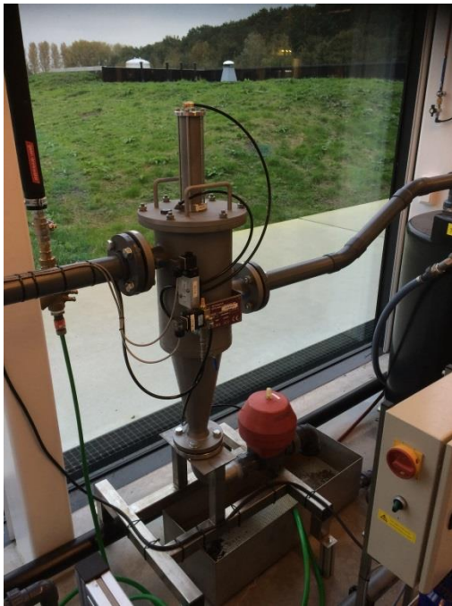
FIGUUR VIII-1 GROF ACF M002P FILTER INCLUSIEF OPVANG BAK
