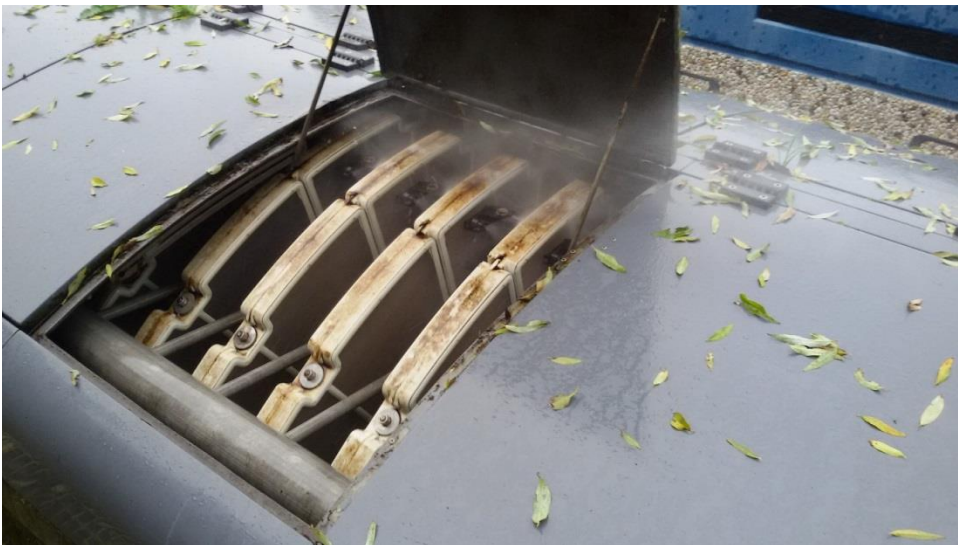
FIGUUR IV-5 DISC FILTER (4 STUKS VAN DE 16 IN TOTAAL) TIJDENS SPROEIEN.
