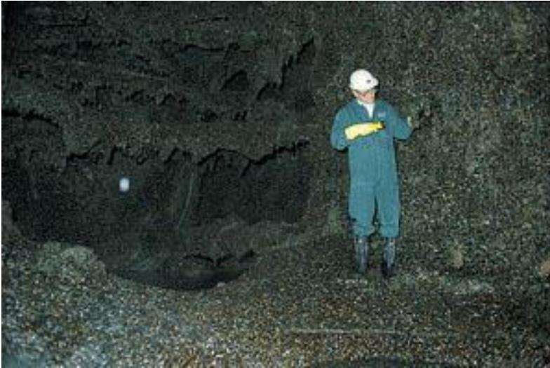
FIGUUR 2-3 AANGROEI MOSSELEN IN EEN POMPENKELDER
